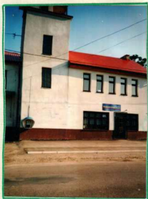
Remiza po rozbudowie. Widok od strony ulicy
